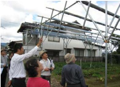
あり、530㎡の宅地(テスト施設のため農地ではない)に147枚のソーラーパネル(太陽光を通すためパネルの縦幅は半分・中国製)が3.5mの高さに35度の角度(降雪を考慮)で設置されていました。発電容量は14.7kw。遮光率は35%で、地上にはサツマイモとアシタバが植えられていました。支柱の間隔は5m(農業機械等が通せる幅が必要)で、すぐに農地に戻すことが可能なように、基礎工事で固定することは許可されないため(鉄板を入れて補強することは可)、支柱は地中1.5mの深さまで埋め込まれていました。(昨年の台風時なども含め)強度についても特に問題はないとのことでした。この施設は1年2月前(視察時)に設置され、当時で総
